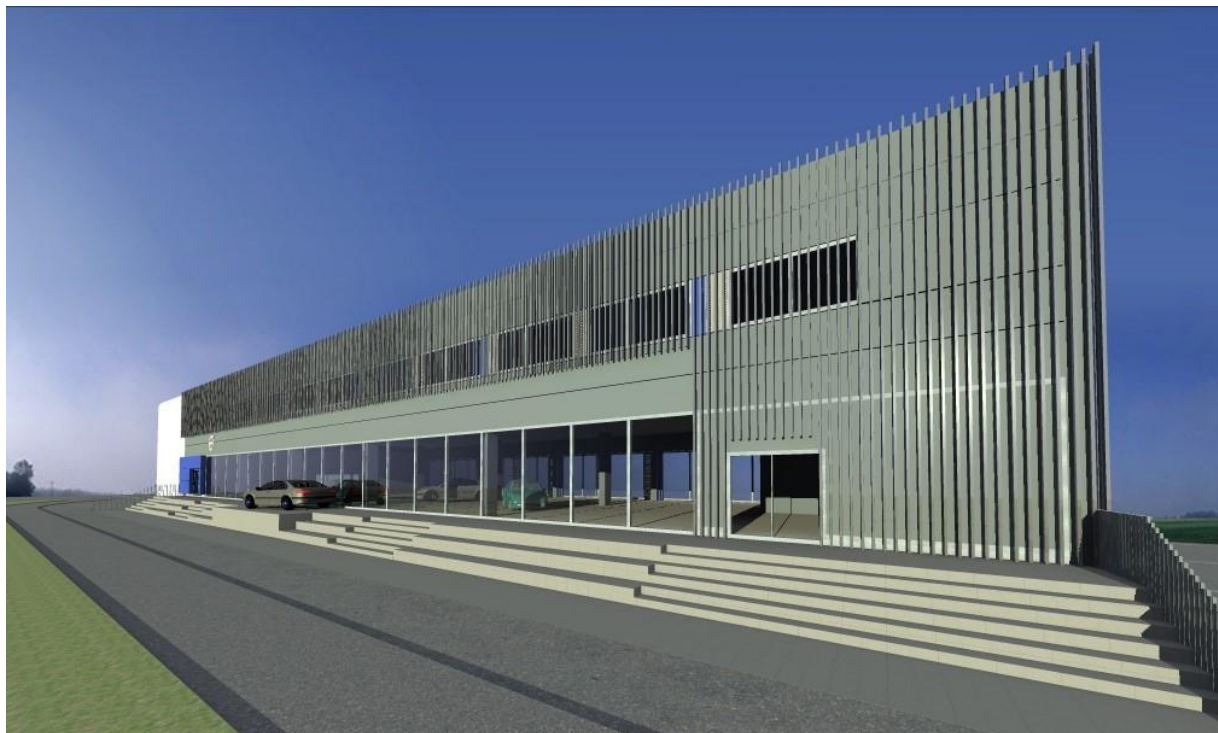
Слика 3 – Објект Злокуќани – предна страна, кон Ул. Скупи, по завршување на изградбата
