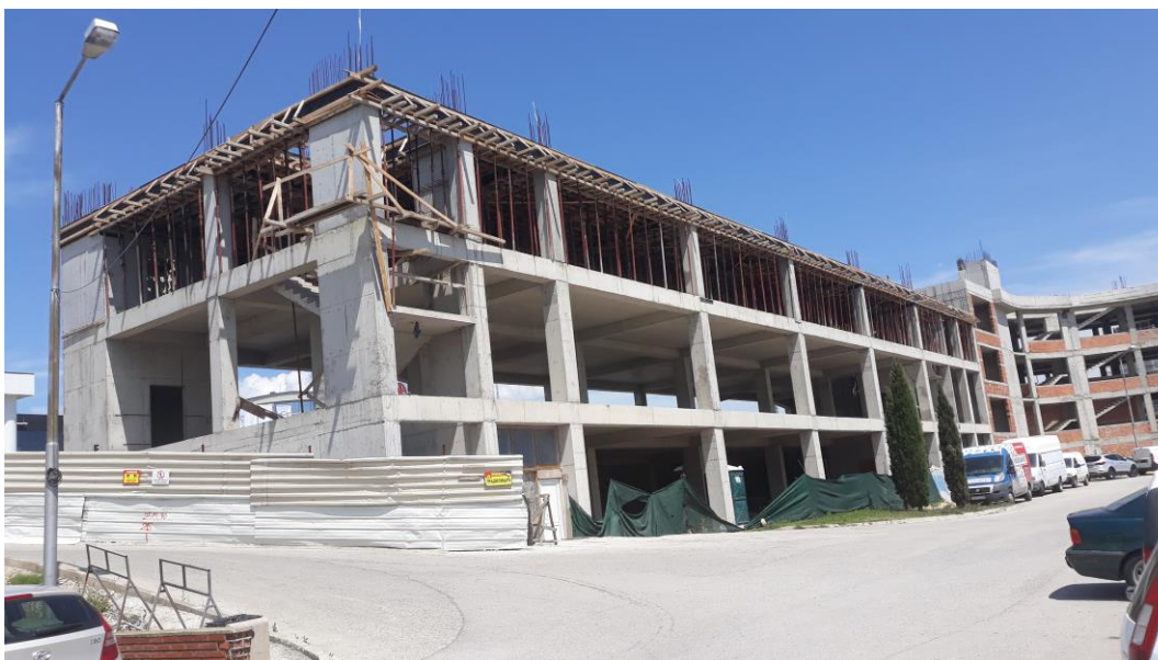
Слика 2 – Објект Злокуќани – од задна страна, моментна ситуација
