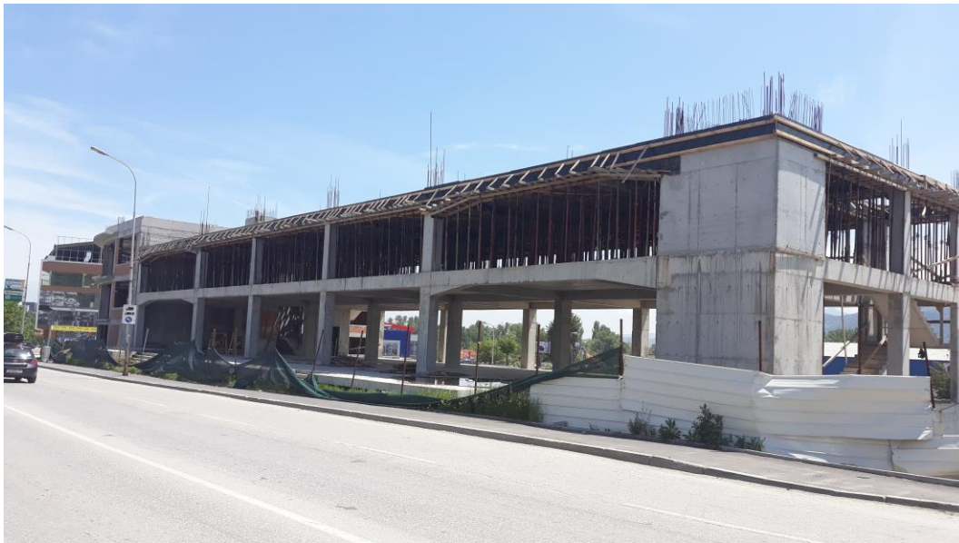
Слика 1 – Објект Злокуќани – предна страна, кон Ул. Скупи, моментна ситуација
