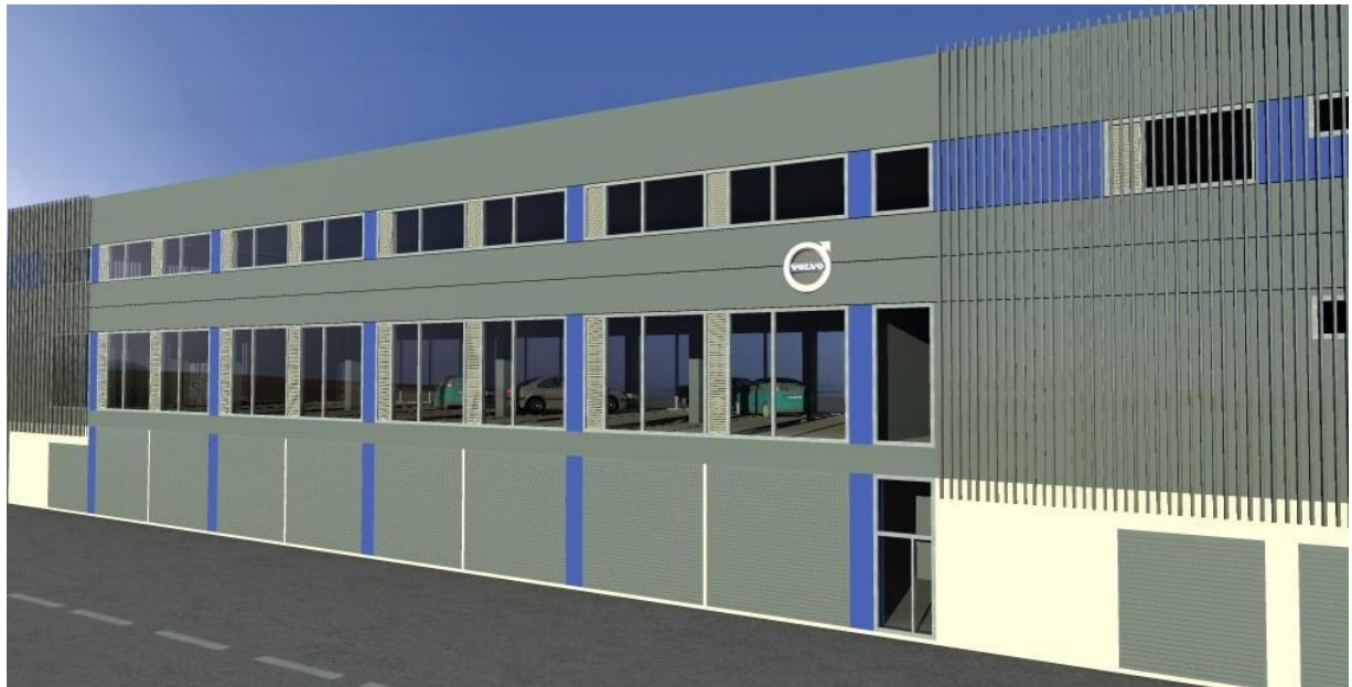
Слика 4 – Објект Злокуќани – од задна страна, по завршување на изградбата
